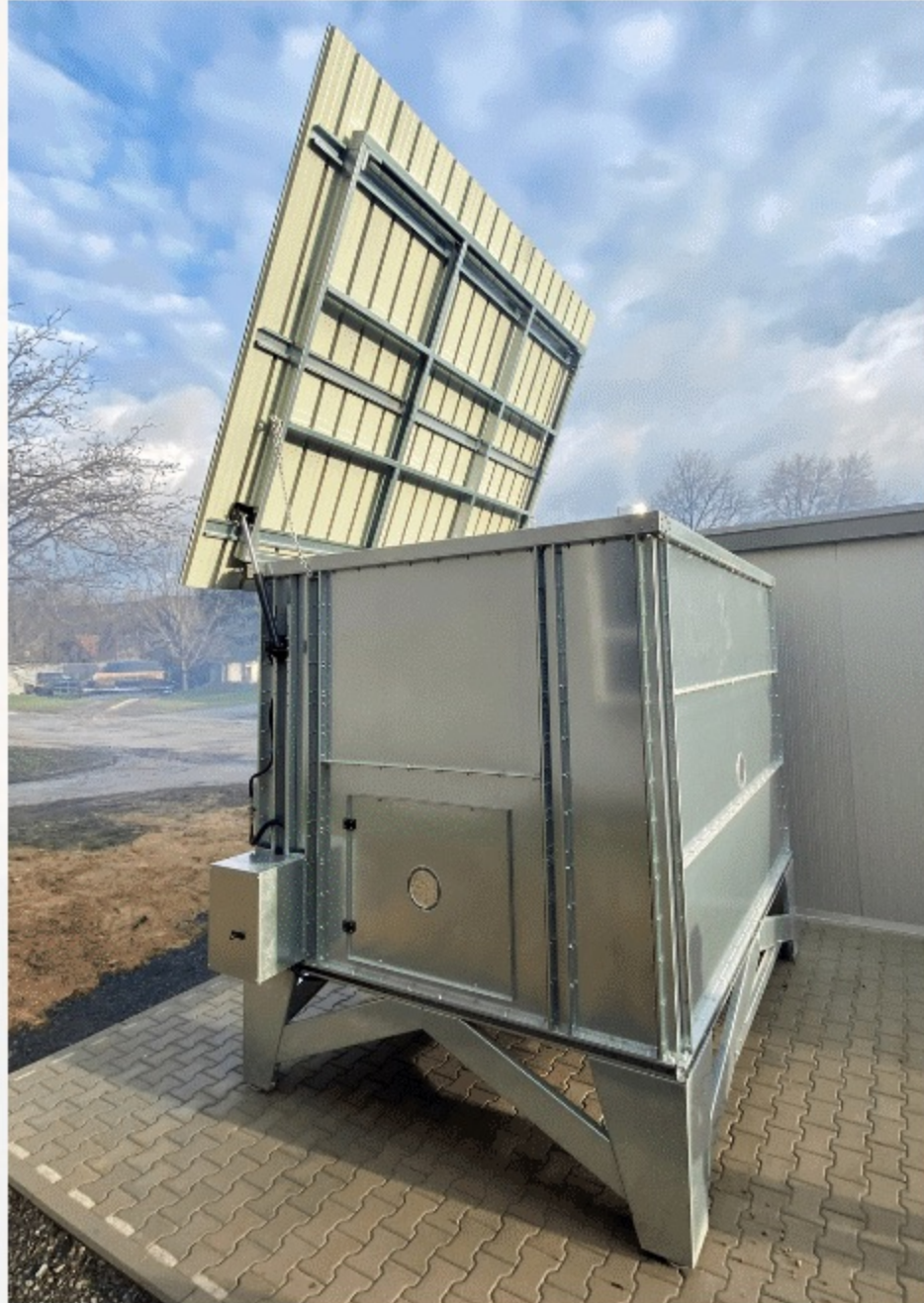
Serbatoio esterno per bio combustibili
